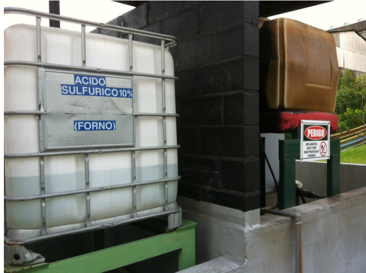
Figura 25 – Construção de mureta para separar as bacias de contenção Fonte: ilustração fornecida pela Empresa A
